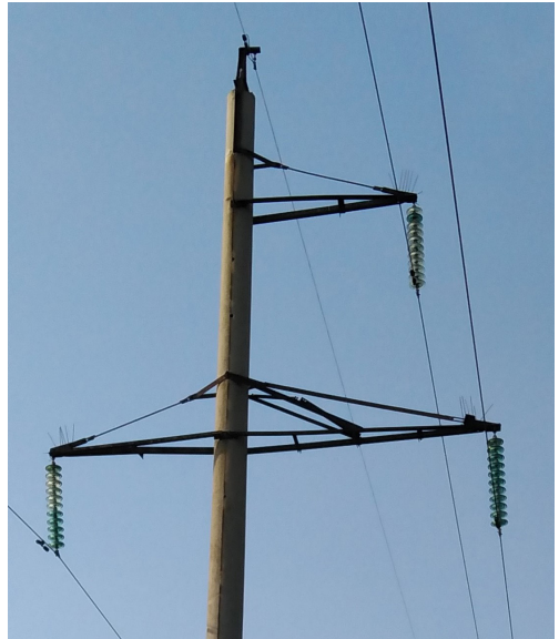
Фото 100. Птахозахисні пристосування в стовпі високовольтної ЛЕП. 2021 р., ок. м. Очаків. Фото К.О. Редінова.
